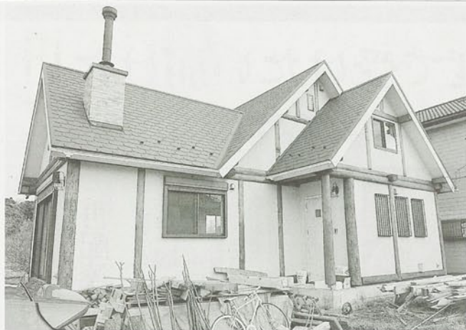
完成に近づいた井上源太郎さんの家。下は内装=いずれも2月、茂原市
